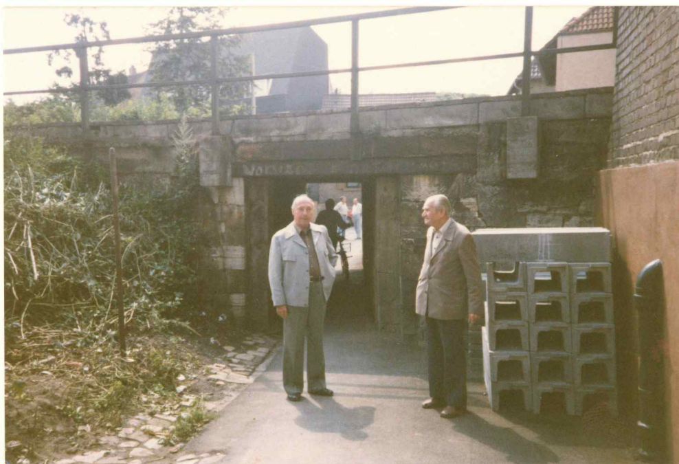
Das Tunnelchen in Höhe der Jahnstraße
